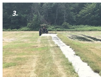
Fig.3: Chiusura tradizionale di un fossato, pianura padana occidentale, IT photo: Laura Zavattaro
